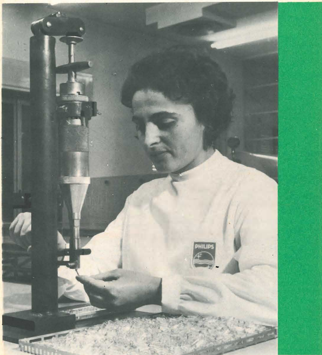
Preparazione dei palloncini di vetro per un tipo di transistor.
